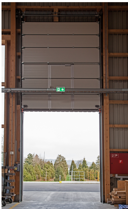
Industrie Sectionaltor Vertikalbeslag auf Holz montiert
